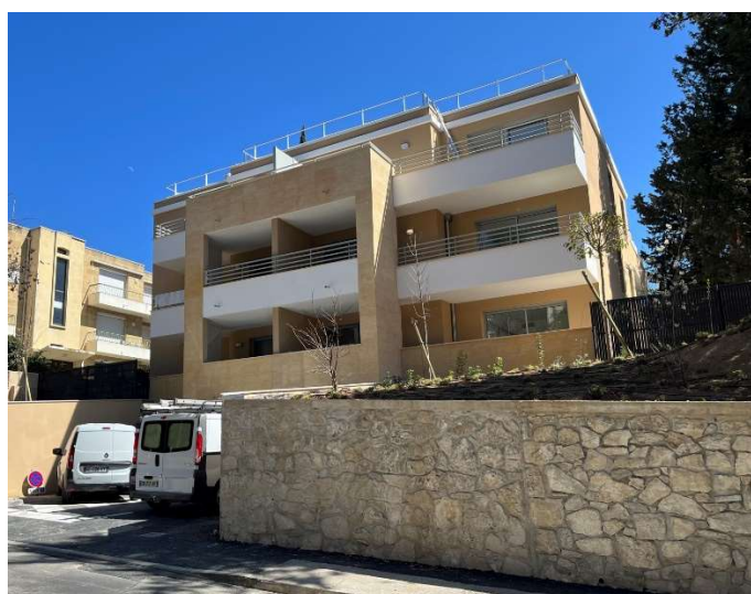
Rue Façade Sud
